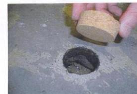
**Entkopplung** erfolgt durch Einsatz spezieller Sanierungsmaterialien, wie z. B. Spezialverschlusskorken, oder Randfugen-Repair. Hierdurch wird eine einwandfreie professionelle Instandsetzung erreicht.
