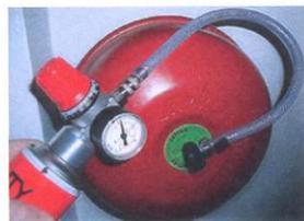
**Bei Verlust von Heizungswasser** wird zuerst das Membranausdehnungsgefäß auf Funktion und Dichtheit der Membran untersucht. Dieses erfolgt durch Druckprüfung des Vorlagen-drucks im MAG mit Spezialgas. Oft ist so der vermeintliche Rohrbruch durch Austausch des MAG erledigt.
