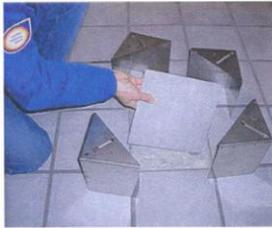
**Fliesen ablösen** erfolgt beschädigungsfrei durch thermische Abschottung und Erhitzung. Die hierbei erzeugte kontrollierte Dehnung der Materialien löst Fliesen aus Klebett und Mörtel. Nach erfolgter Reparatur können so die Originalfliesen wieder eingesetzt werden.
