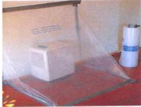
**Bautrocknungsgeräte** werden nach vorliegenden Rahmenbedingungen auf effektivste Art betrieben und überwacht. Hierdurch werden Trocknungszeiten zur Kostensenkung auf ein Minimum reduziert. Bei partiellen Schäden wird die Trocknung in Abschottungen aus atmungsaktiver Folie vorgenommen. So kann hohe Trocknungsleistung gezielt auf die Schadstellen kompenziert werden.
